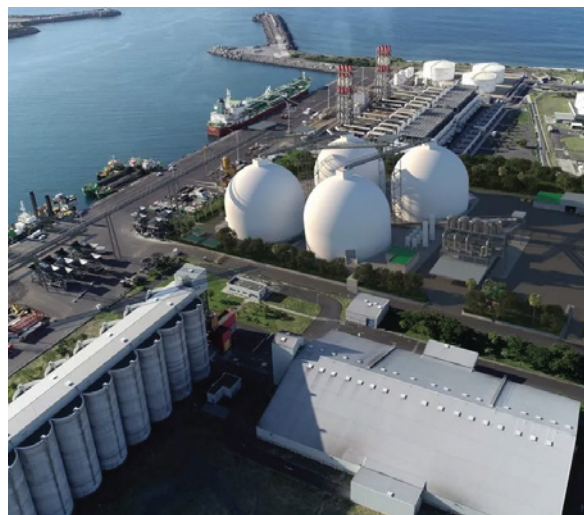
Site de réception des pellets du Port. Source : Albioma.
